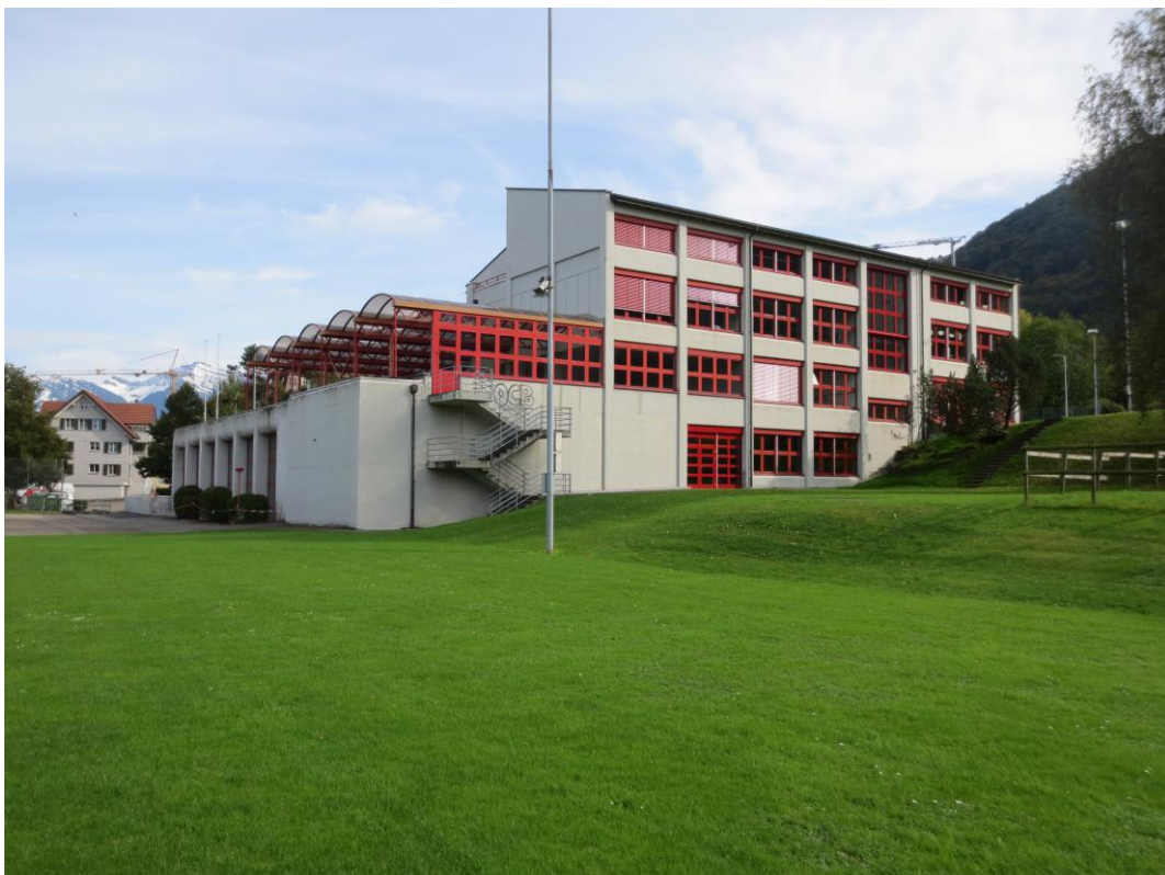
Die Mehrzweckhalle „Gutenbrunnen“ in Schübelbach, Tagungsort 2025
